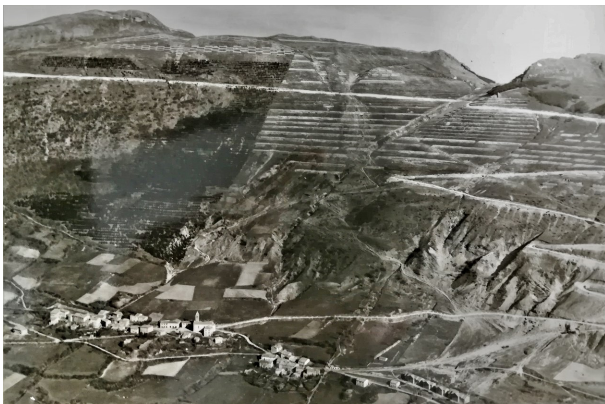
Figura 9.3 – Panoramica che raffigura il versante sud-ovest del Monte Valvassetto (a sud) e Sassotetto (a nord) con le frazioni di Villa di Mezzo (Pepoli) e Villa da Capo (Malvezzi). E' evidente lo scenario post-valanga con i primi terrazzamenti per i lavori di rinboschimento al fine di rimodellare il versante interessato da fenomeni di erosione.
